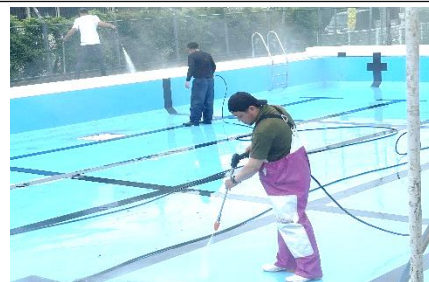
高圧洗浄機を使った清掃の様子
