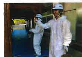
【増田小での塗装作業】
