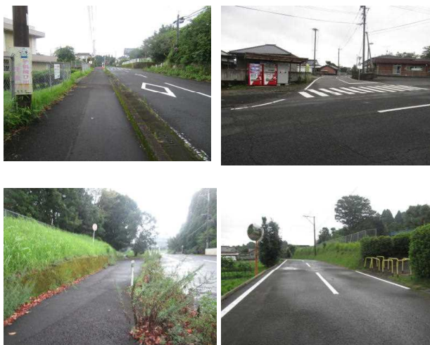
8月7日(木) 校区危険箇所点検
